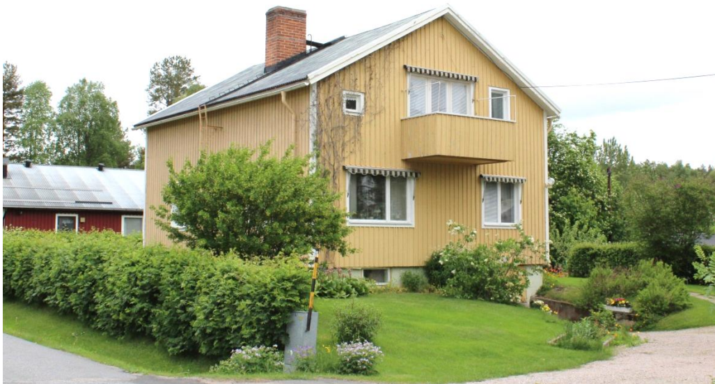
Figur 14. Egnahem med källargarage. Krookskavägen i Övertorneå
