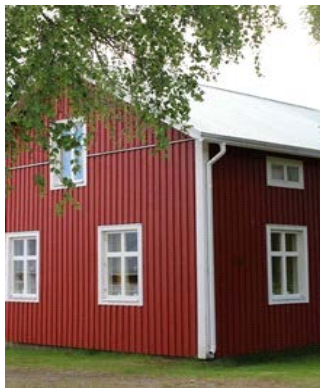
Figur 10. Bra exempel på fönsterbyte, Juoksengi 17:4
