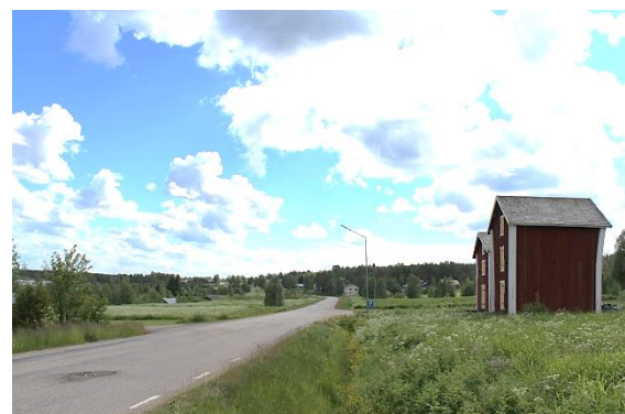
Figur 76. Vasaittor vid riksväg 99
