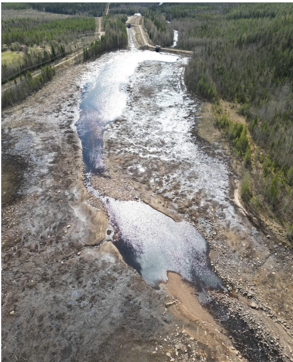
Figur 8 Drönarbild, medströmsvy. Dammkonstruktion i överkant i bild. Notera att vattennivån i bild inte är avsänkt till lägsta möjliga nivå (Norconsult 2025-05-20).
